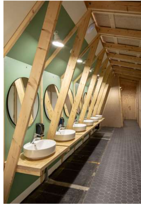
▲ Sanitaires de l'espace de coworking (lamellé-collé moisé, peinture verte sur MFP)
