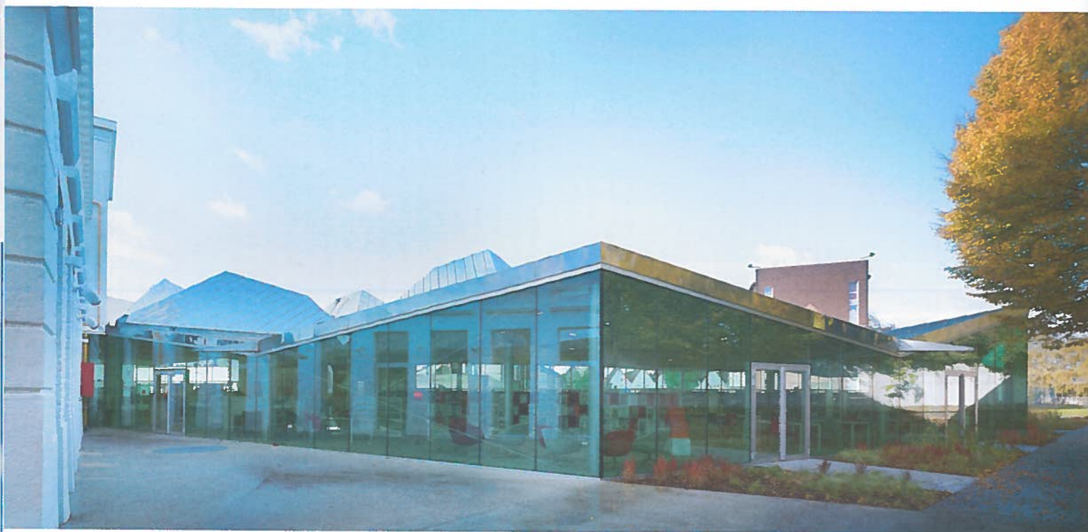
▲ La couverture en zinc du toit et les vitrages toute hauteur ceinturant l'extension génèrent des jeux de reflet.
