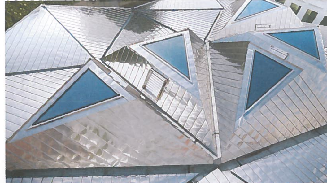
▲ Recouverte de zinc à joint debout, la toiture comporte 30 pyramides dont 9 sheds.
