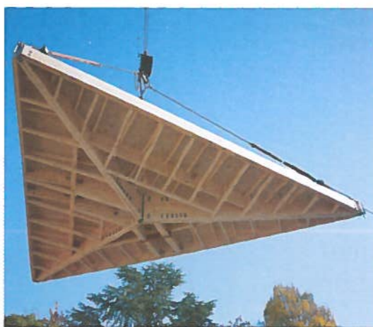
▲ Levage d'un caisson sur le chantier.
