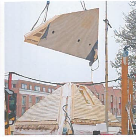
▲ Les sheds ont été entièrement préfabriqués en atelier.
