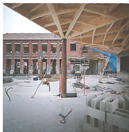
▲ Les caissons reposent sur des poteaux métalliques.
