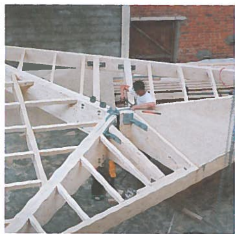
▲ Assemblage d'un caisson en atelier
